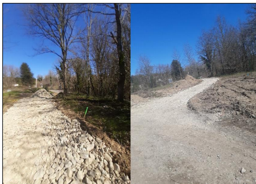
Figure 22 : Mise en place des pistes lors d'un chantier photovoltaïque (Source : TECHNIQUE SOLAIRE)
