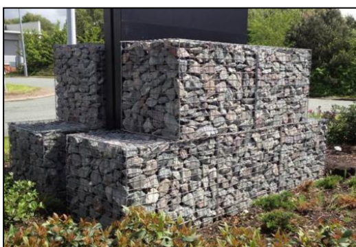
Figure 20 : Exemple de muret en gabion (Source : TCS Geotechnics)
