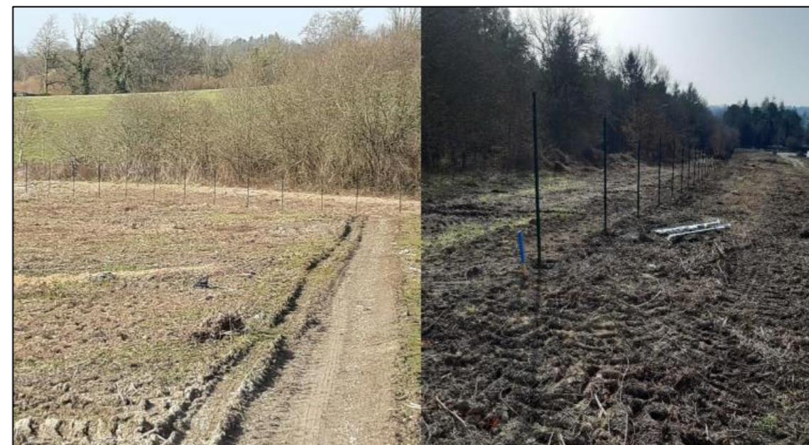
Figure 23 : Exemple de pose de clôture lors d'un chantier photovoltaïque (Source : TECHNIQUE SOLAIRE)
