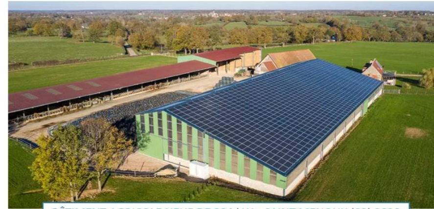
BÂTIMENT AGRICOLE NEUF DE 324 kWc, SAINT-MENOUX (03) 2020
