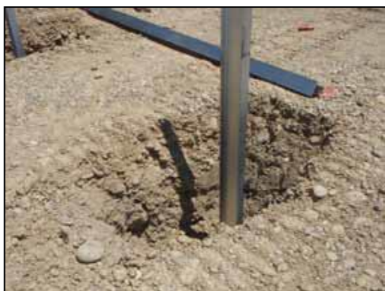
Figure 18 : Types de fondation - pieux battus (Source : Guide MEDDTL 2011 – NCA, 2015)
