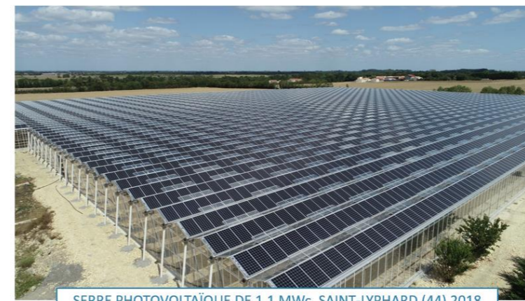
SERRE PHOTOVOLTAÏQUE DE 1,1 MWc, SAINT-LYPHARD (44) 2018
